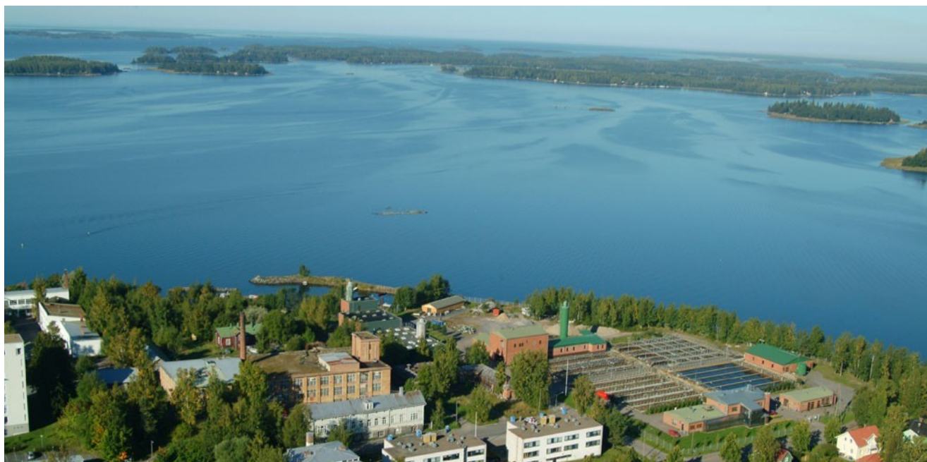
Påttin jätevedenpuhdistamo Palosaarella
