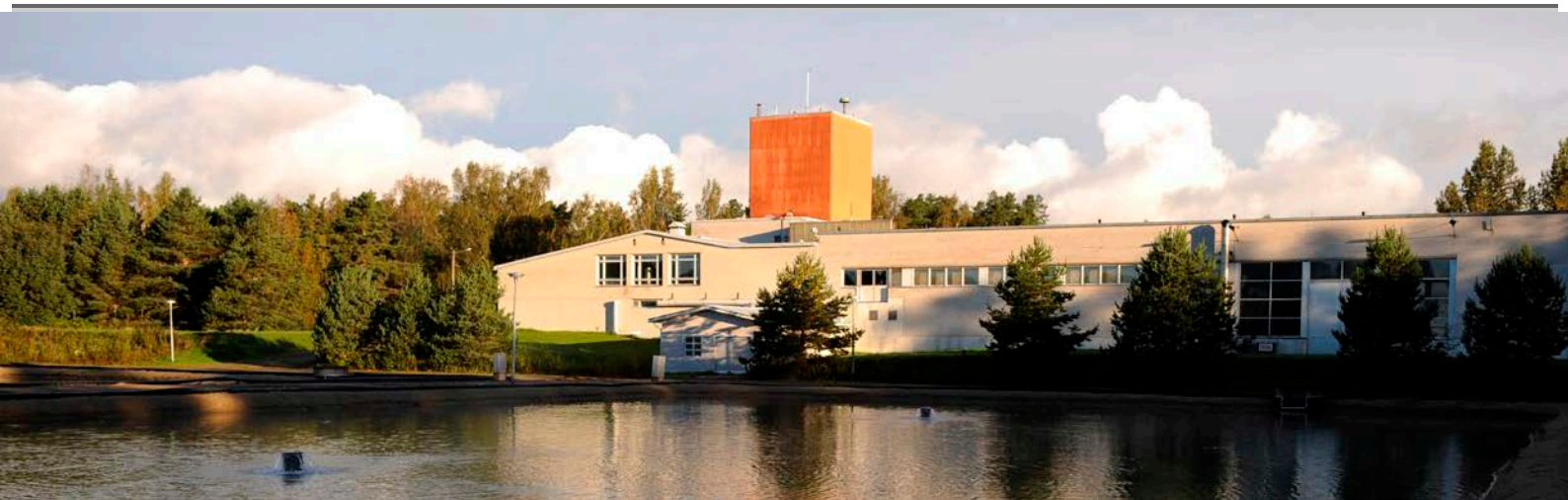
Kuva: Vaasan Veden kuva-arkisto
