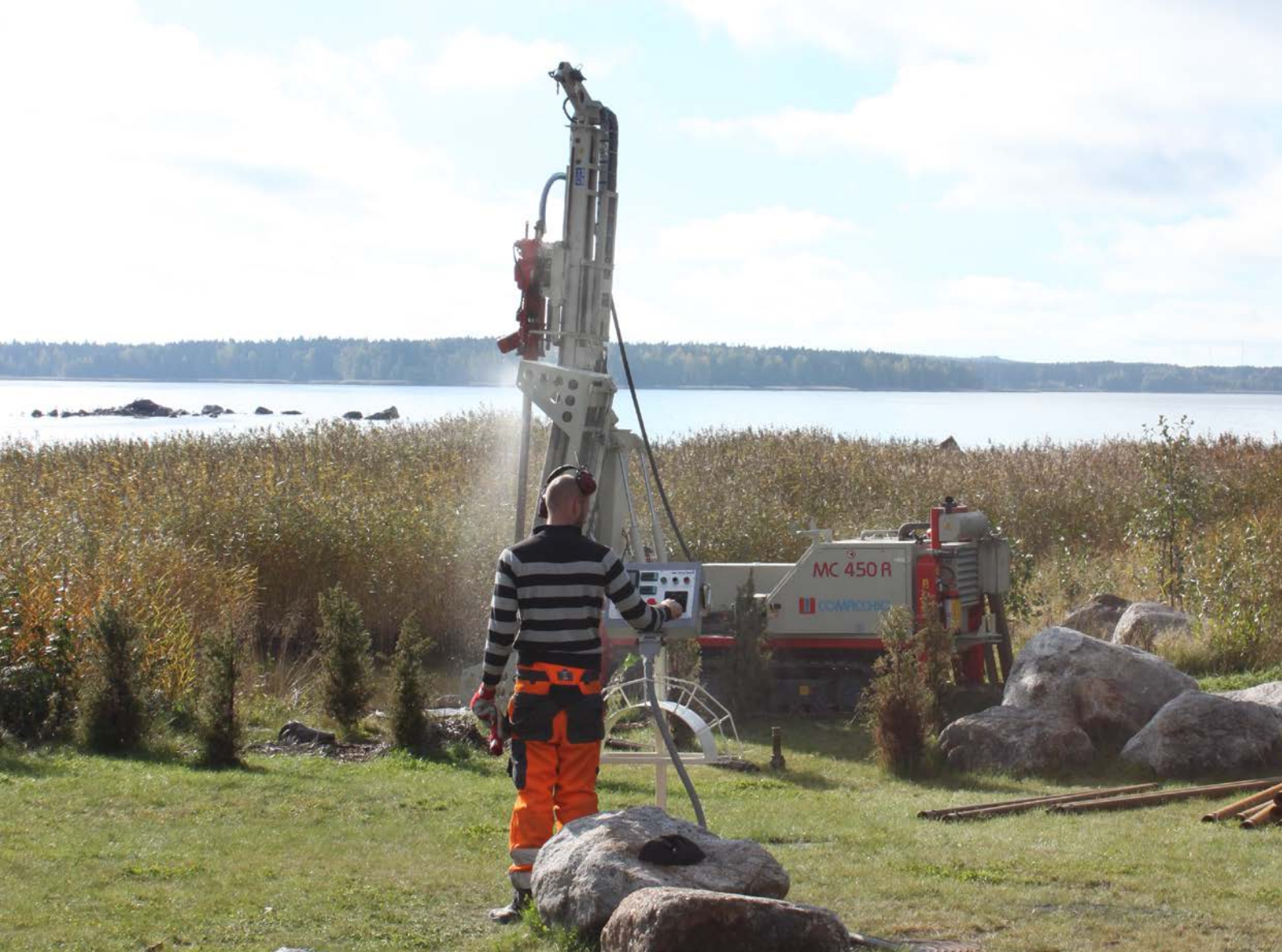
Kuva: Vaasan Veden kuva-arkisto
