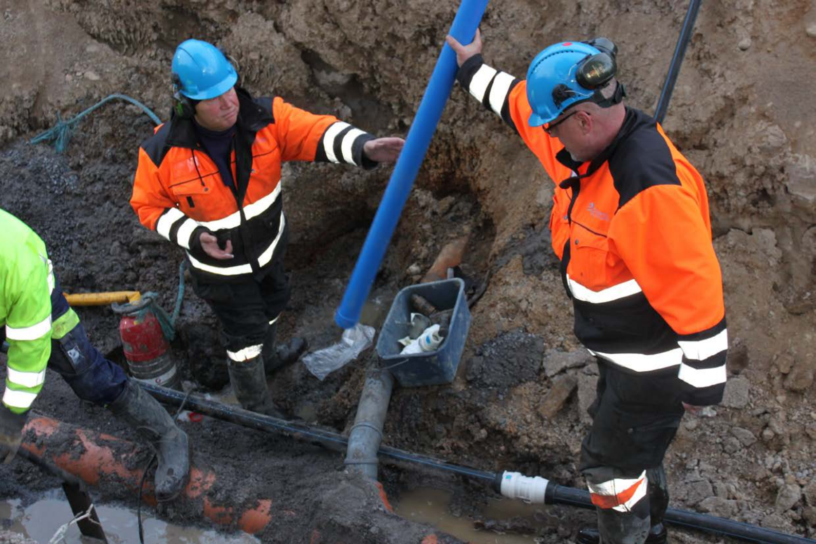
Kuva: Vaasan Veden kuva-arkisto
