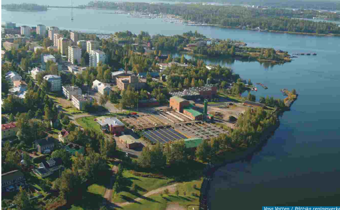
Vasa Vatten / Pättäskä reningsverket
